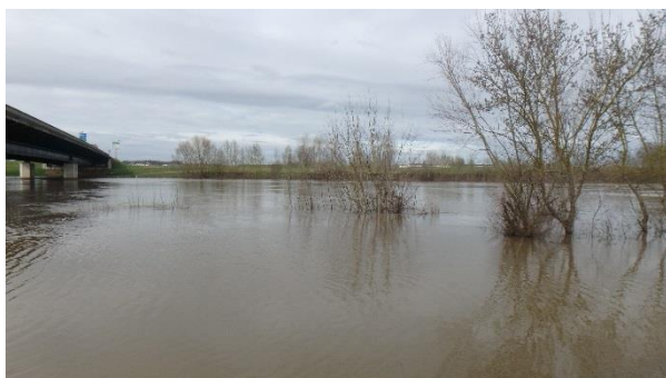
Le Cher au droit du périphérique
