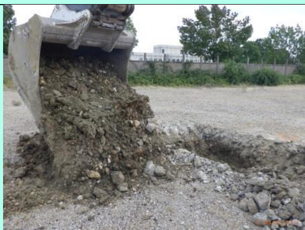
Recherche de matériaux amiantés à chaque pelletée
