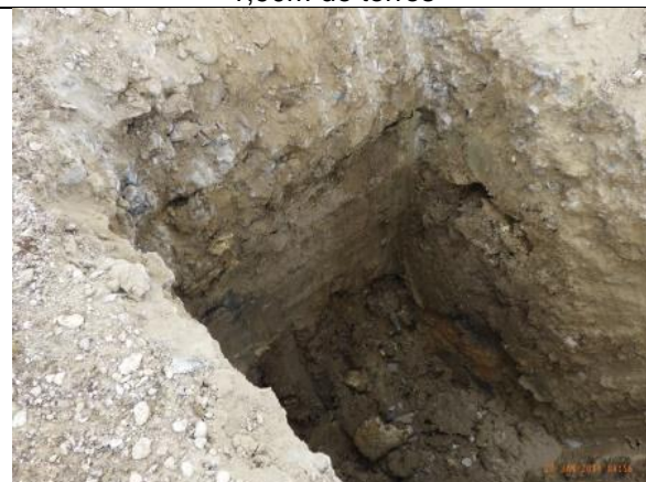
Sondage N°14 1,00m de 0/120 – 2,00m de terres
