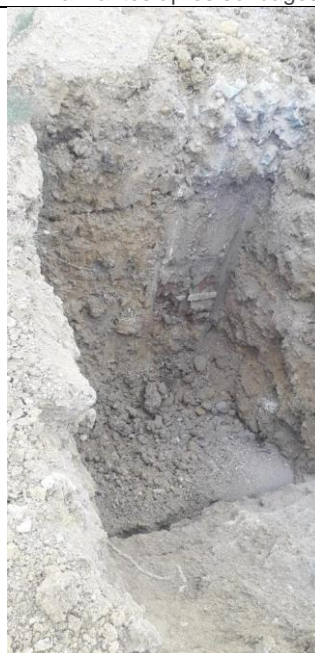
Sondage N°22 1,00m de 0/120 – 2,00m de terres
