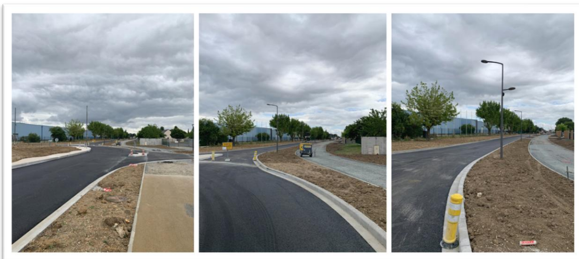
Une première tranche de travaux a été effectuée sur la route de Monts.
