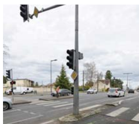
Le carrefour avant travaux
