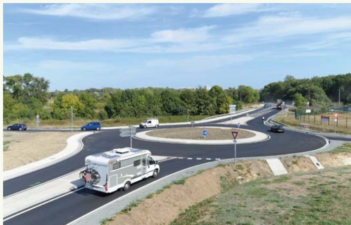
Giratoire porte de Villandry
