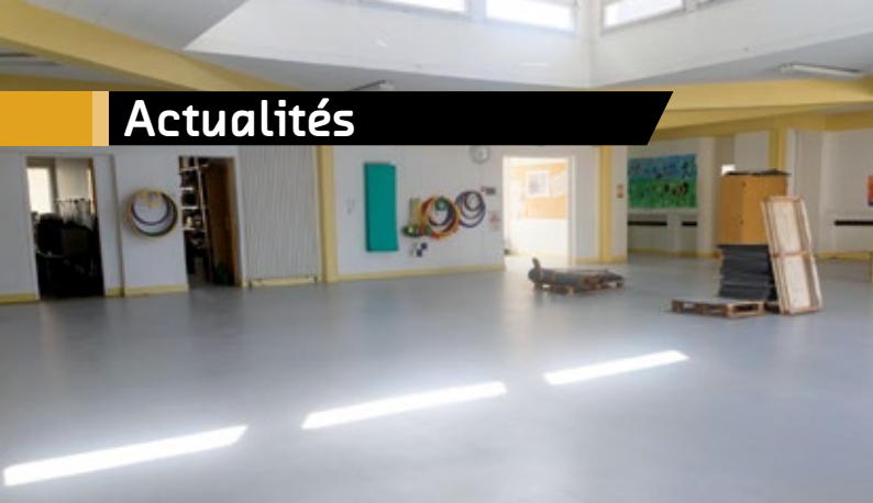
Réfection des sols au groupe scolaire de la Vallée Violette.
